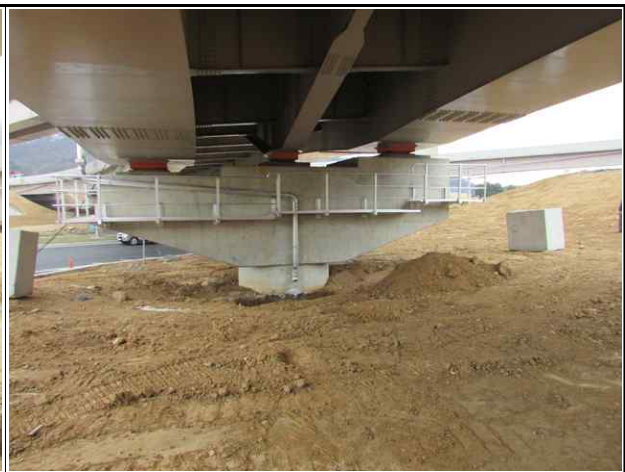
교각 P2 전경
