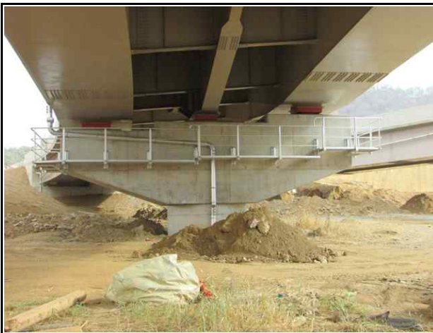
교각 P1 전경
