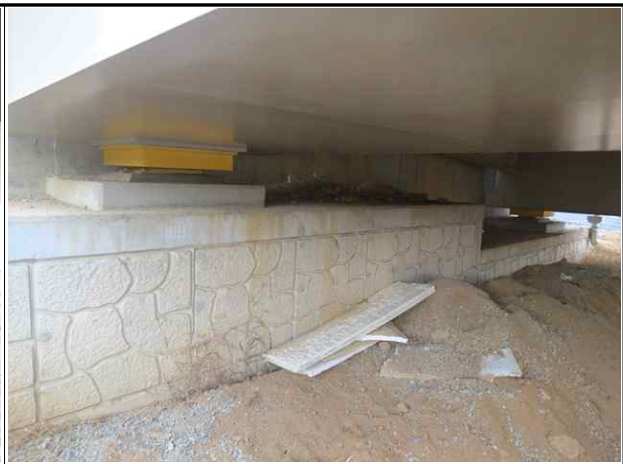
교대 A2 전경
