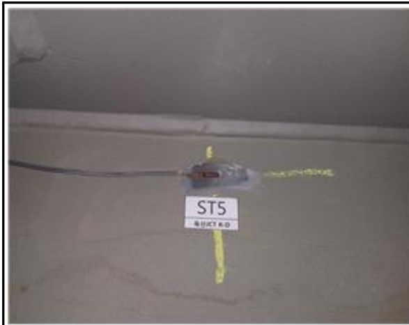
변형률계 설치 현황
