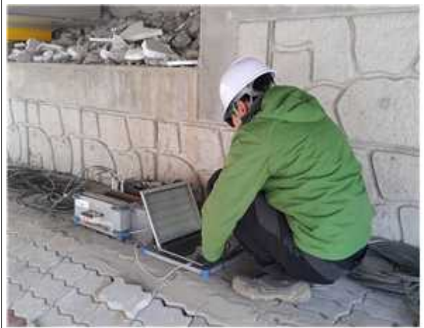
재하시험 계측 전경
