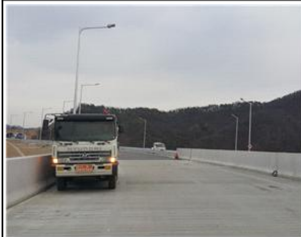
정적 재하시험 전경
