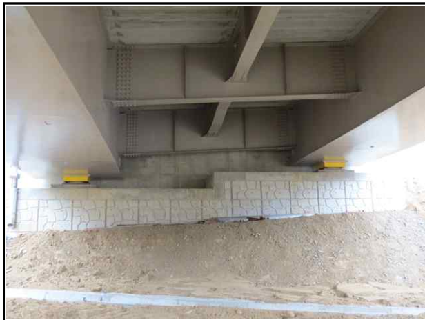
교대 A1 전경
